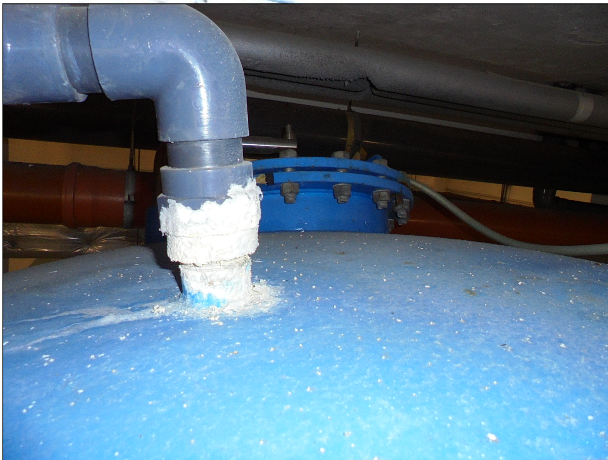
Rysunek 10 FILTR FII F2.1 (przeciek z króćca odpowietrzenia)
