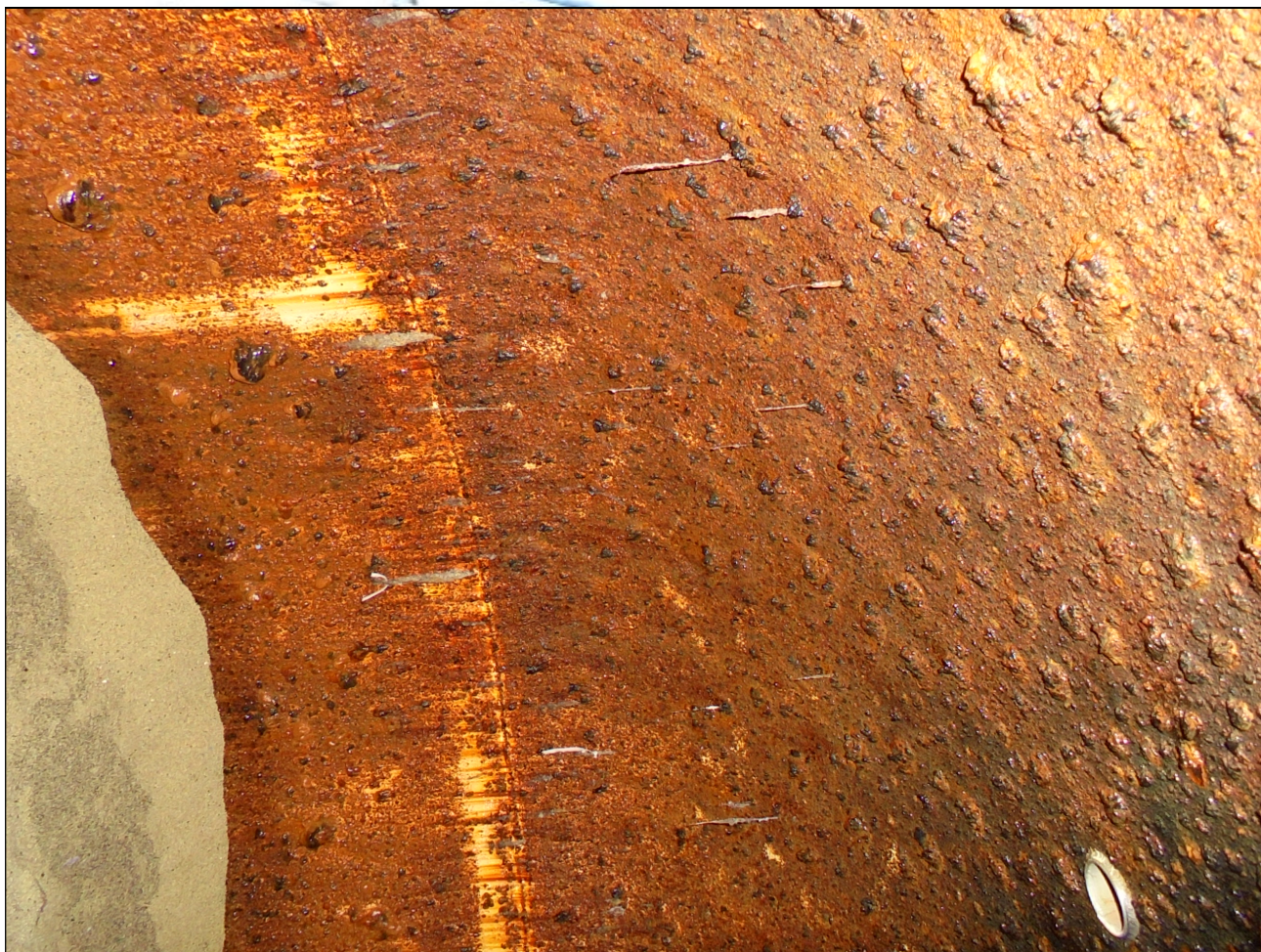
Rysunek 15 FILTR FII 2.2 (widok części kopuły i ściany bocznej filtra)
