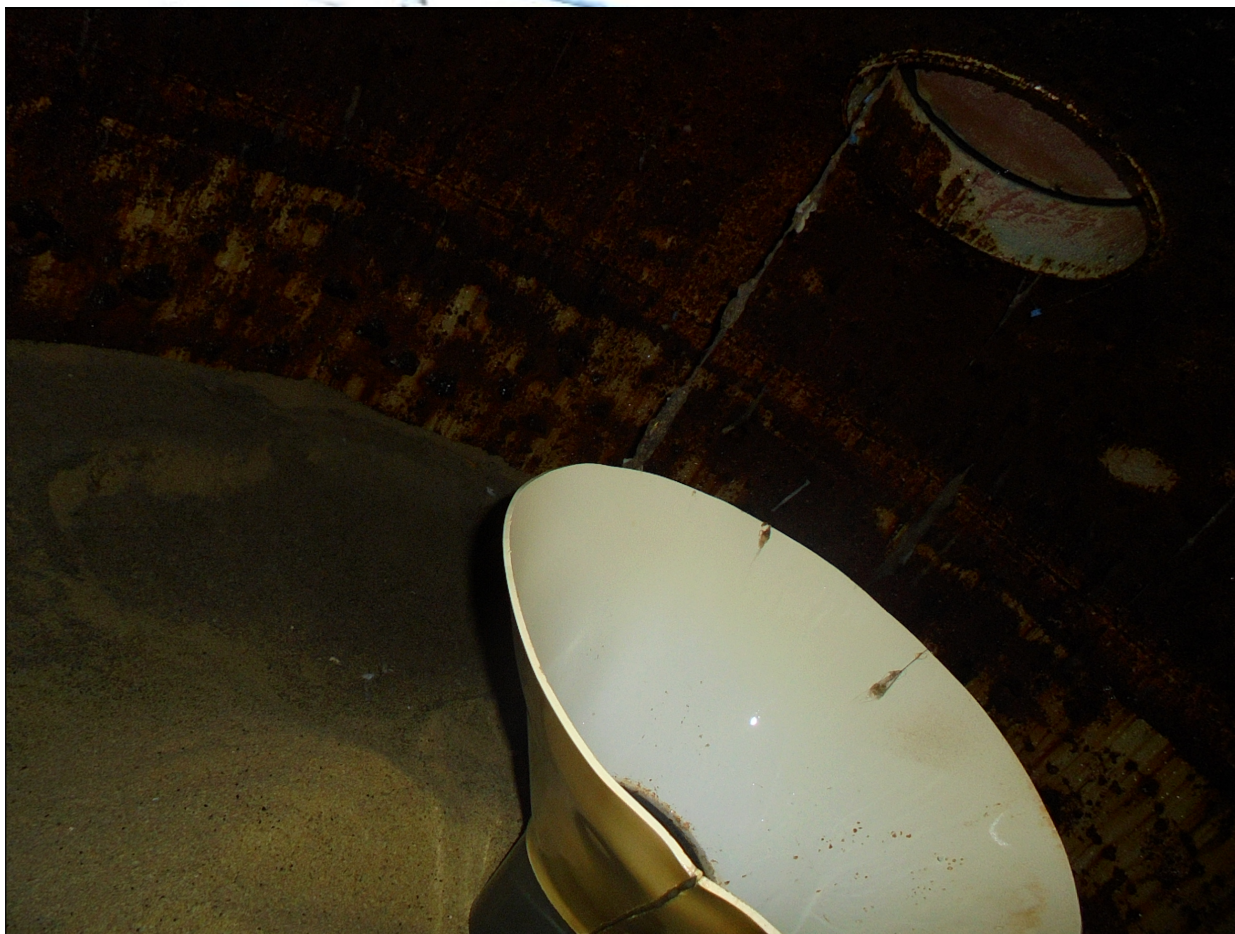
Rysunek 11 FILTR FII F2.1 (widok złoża, wlotu górnego i ściany wew. filtra)
