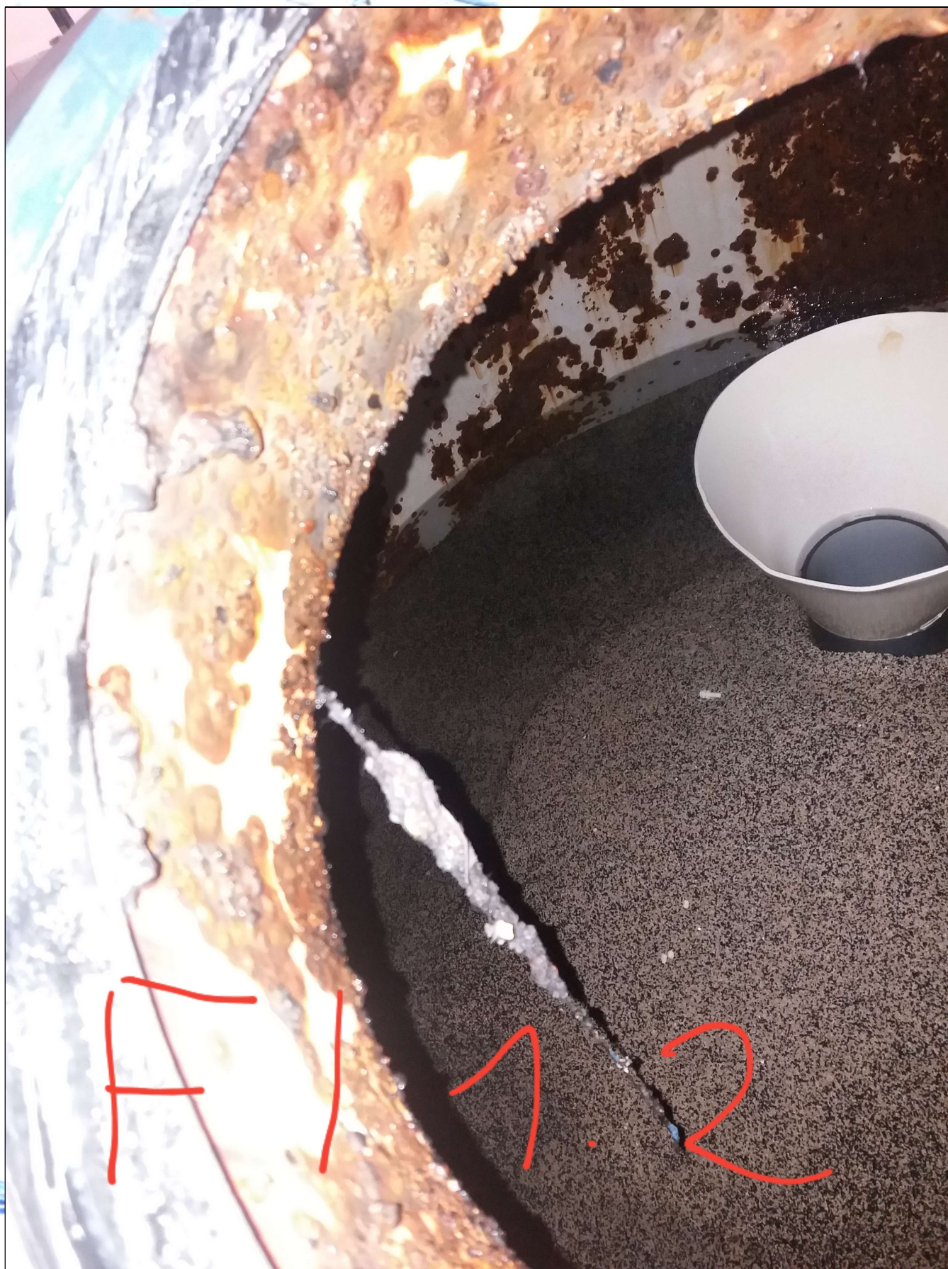
Rysunek 9 FILTR FI 1.2 (widok złoża, ściany bocznej i części wew. otworu włazowego)
