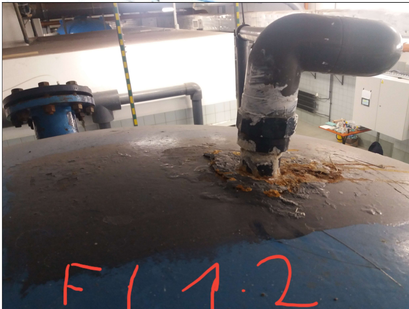
Rysunek 7 FILTR FI 1.2 (przeciek odpowietrznika)
